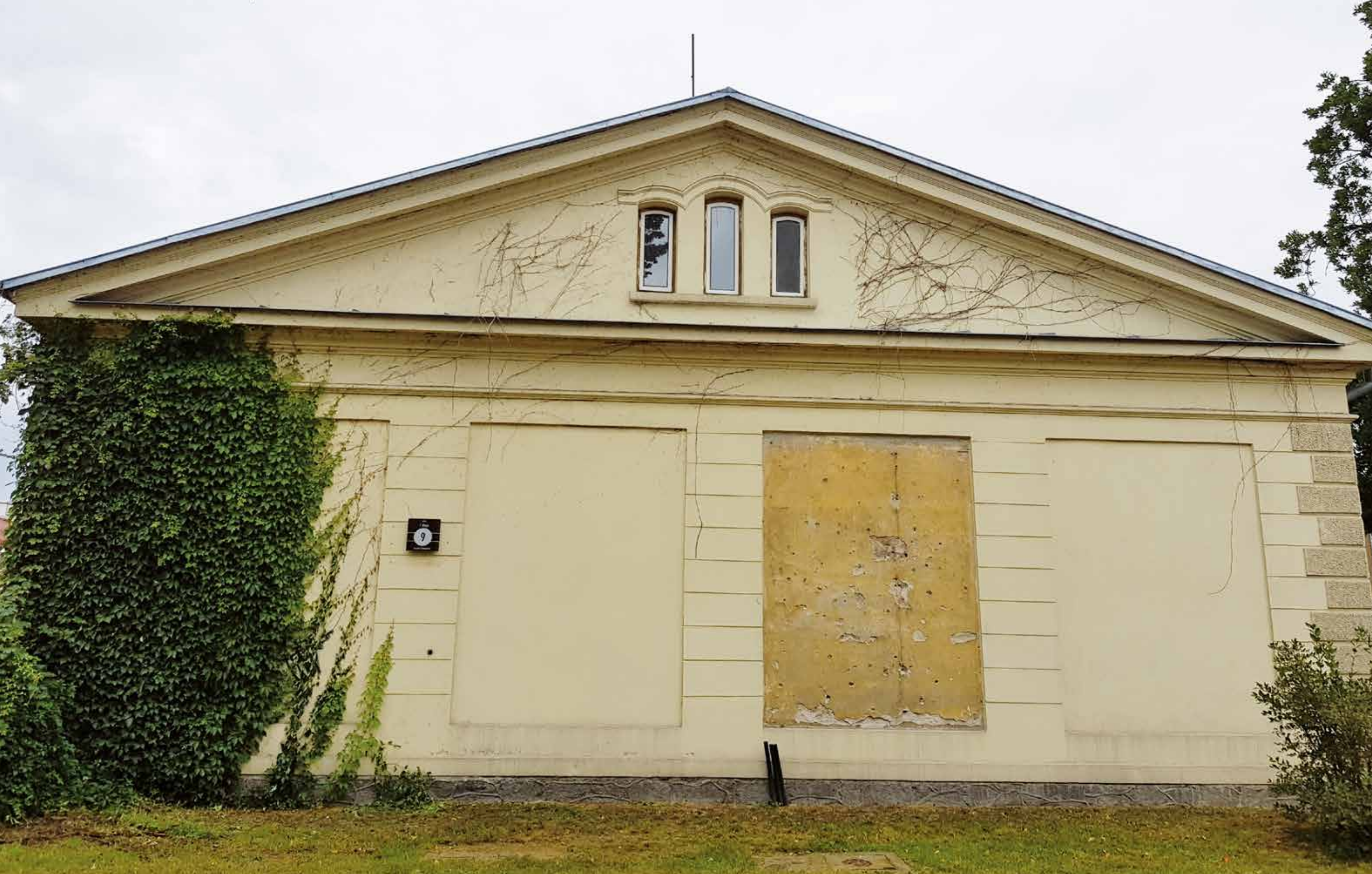
Budynek przy ul. 1 Maja 9 na którym zachowały się ślady walk z 1920 r., 2020 r. fot. Aleksandra Gryspanowicz
